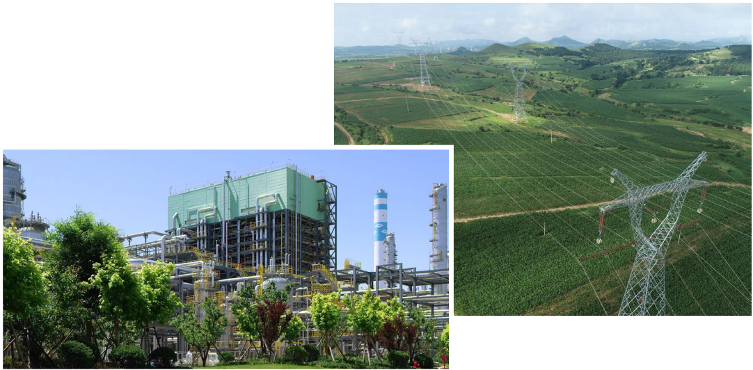
辽宁川州 500 千伏输变电工程
