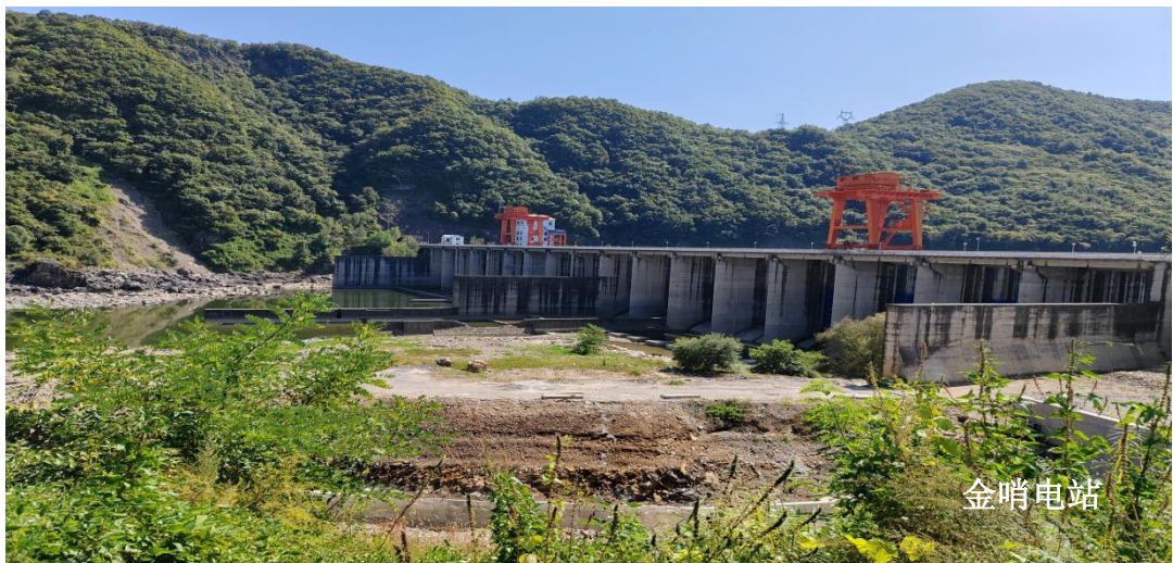
图 1.5-1 水库（水电站）现场照片
