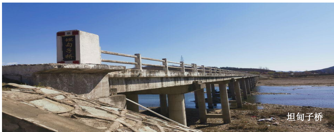
图 1.6-1 浑江跨河桥梁现场照片
