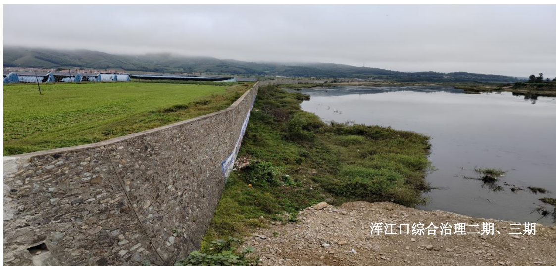
图 1.5-2 堤防现场照片
