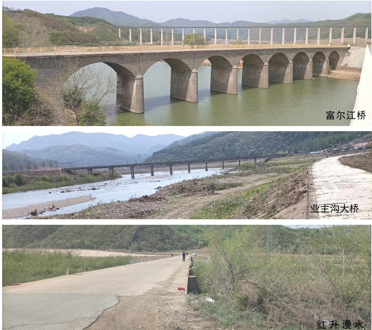
图 1.6-1 富尔江跨河桥梁现场照片
